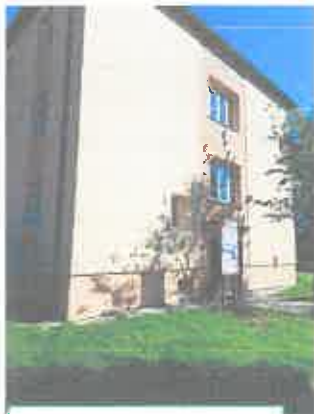
Nová fasáda na budově pobočky v Sokolově
